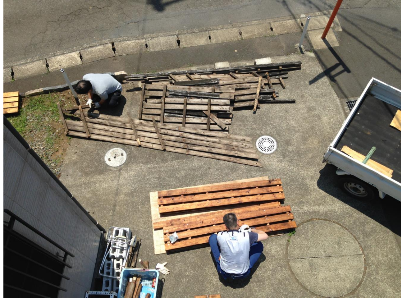
破損スノコ(長3.6m)を分解し新規に作成
