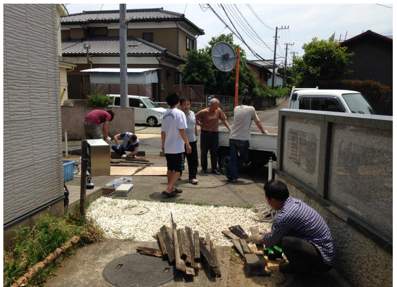
撤去した部材を30センチに整理
